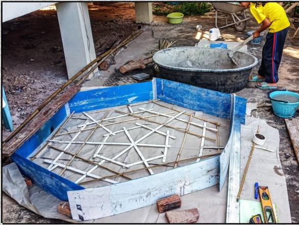
On coule la première dalle, armée avec du bambou et du treillis recyclé. Le mélange est fait en utilisant du sable limoneux tamisé issu du curage d'un fossé. On reste sur une source locale.
